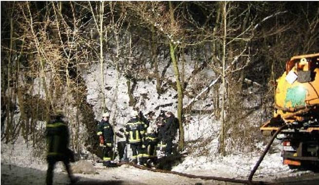
Nach dem Absaugen wurde verunreinigtes Erdmaterial abgetragen. Die Ölsperre blieb noch 2 Tage unter Aufsicht bestehen.
